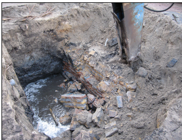
Het slopen van de kademuur
