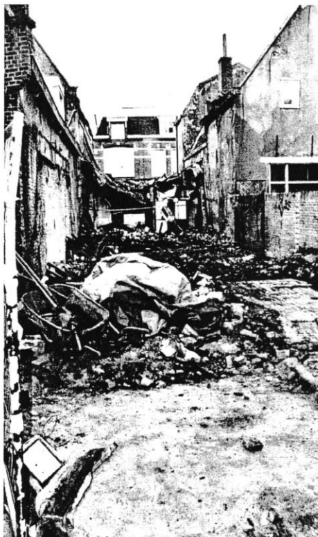
De inmiddels grotendeels opgeruimde resten, na de brand van het pand Padjedijk nr. 11, gezien vanaf de Kromme Steeg (eigen foto).
