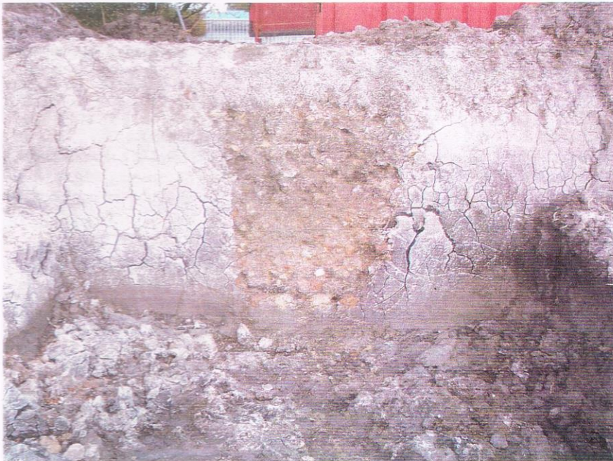
Ingegraven fundatie voor een muur van het klooster
