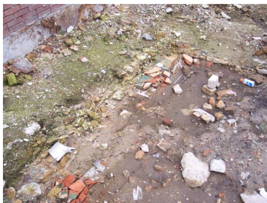
Na de sloop: restanten van de plavuizen
