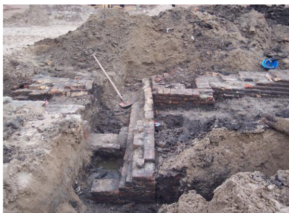
De dwarsmuur vanaf de zijkant gezien
