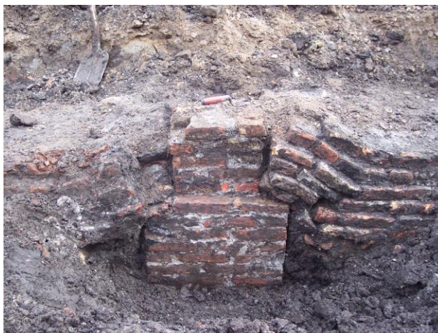
Poer met de verzakte stenen muren.
