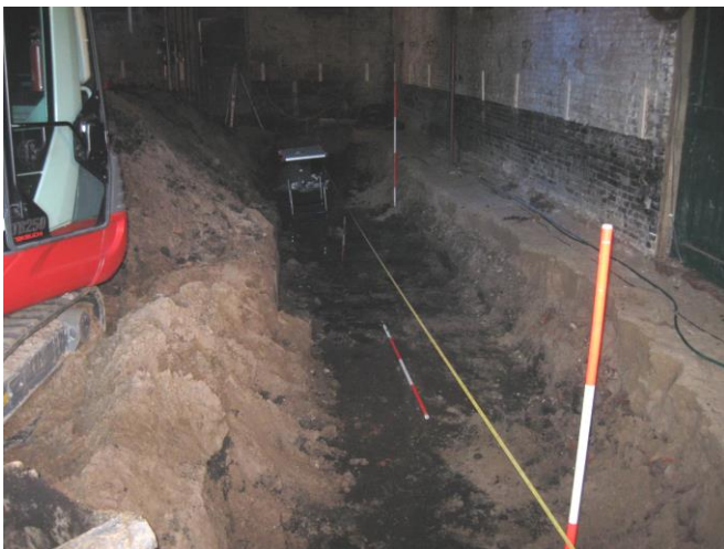
De eerste sleuf in de doelenstallen
