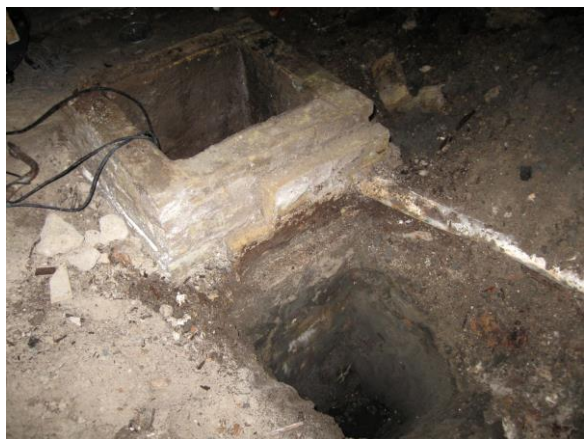
De loden pijp aangesloten op de kraag
