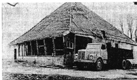
Één van de vele boerderijen in de Purmer die ten prooi vielen aan de slopershamer, de "Stad Zaandam" (foto NNC, 28 december 1984)
